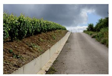
Un ouvrage de bord de route, réalisé en béton et à double fonction de soutènement et de caniveau. Plutôt bien fini, cet ouvrage gagnerait simplement à un enherbement du petit talus qu'il soutient.
