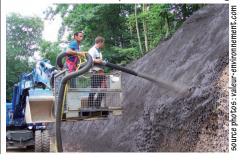
Projection sur un géotextile (de type structure Krismer) d'un substrat terreux associé à de la bentonite (argile colloïdale) et aux semences appropriés.
