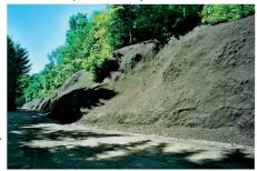
Paroi après travaux, couverte de substrat bentonitique et de semences. La bentonite apporte le liant nécessaire à la tenue du substrat avant la germination des semences.
