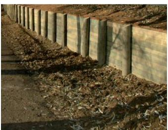
Exemple de petit soutènement réalisé en tunage de bois (source photo : crecylachapelle.eu)
