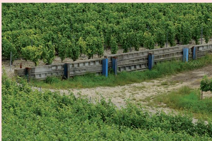
*Autre exemple de dispositif hydraulique (obstacle aux écoulements torrentiels ?) fragilisant le paysage où il s'insère, réalisé celui-ci avec des poteaux EDF en béton*
