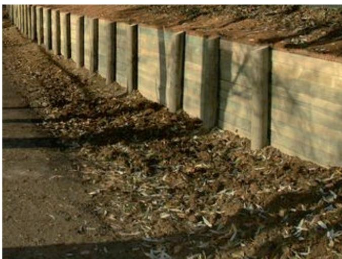
Exemple de petit soutènement réalisé en tunage de bois (source photo : crecylachapelle.eu)
