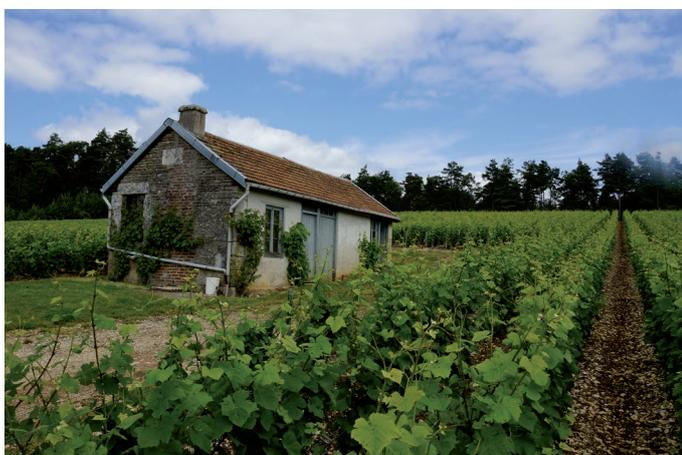
*Un exemple de loge de vigne de belle facture, édifiée en moellon et pierre de taille calcaire, et en brique. (secteur du Replat-Blanc).*
