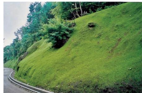
Projection sur un géotextile (de type structure Krismer) d'un substrat terreux associé à de la bentonite (argile colloïdale) et aux semences appropriés.
