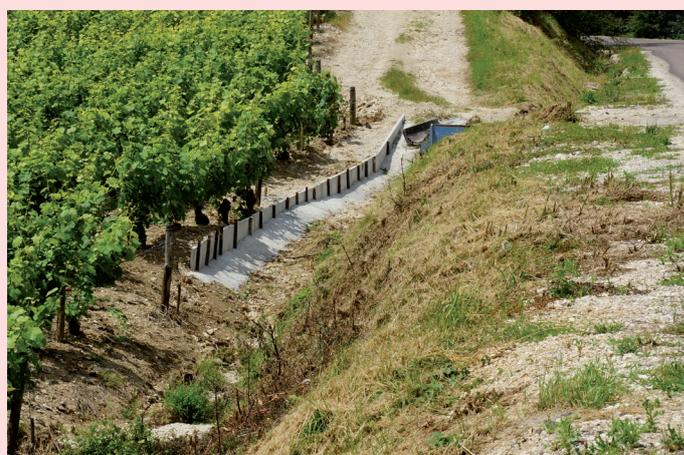
*Les dispositifs mixtes, qui associent fossés et éléments de maçonneries en béton, présentent en général un aspect plus problématique que les systèmes plus unitaires. L'absence d'enherbement et la finition généralement sommaire de leurs maçonneries ne favorisent pas leur discrétion.*
